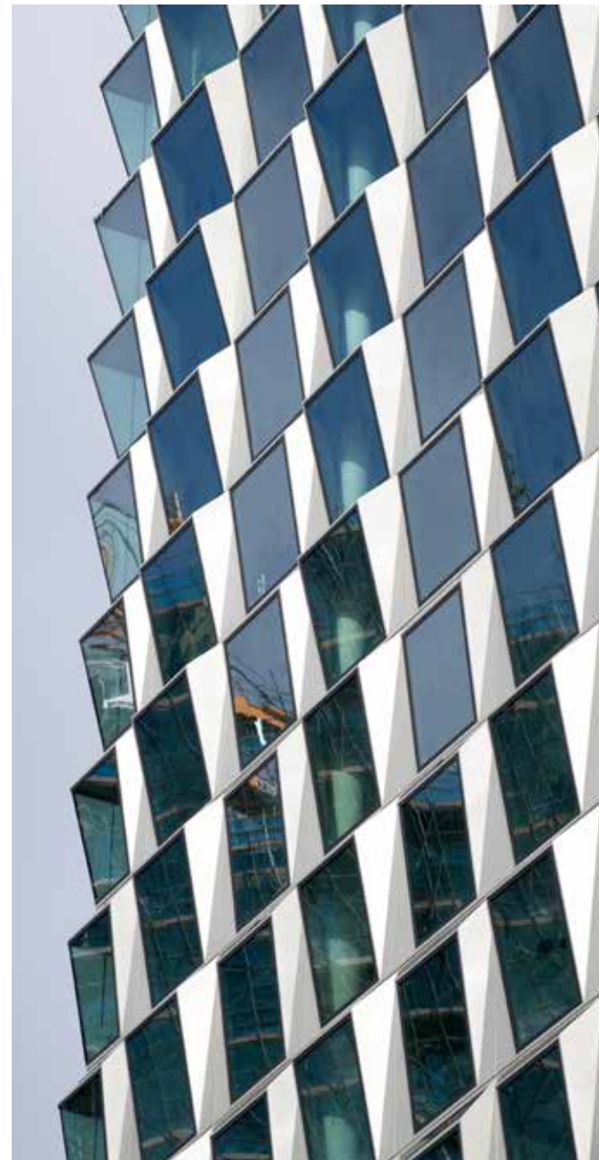
Hoe hoger aan het gebouw, hoe dieper en schuiner de erkers.
