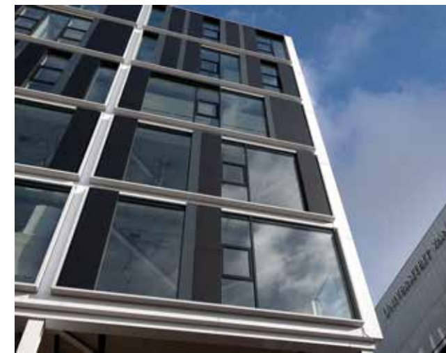
De Universiteit van Amsterdam laat LAB42 bouwen, een energieneutraal onderwijsgebouw met een open en uitnodigende uitstraling.
